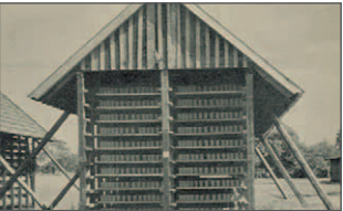
Freilufttrockner für Absetzwagen um 1920
