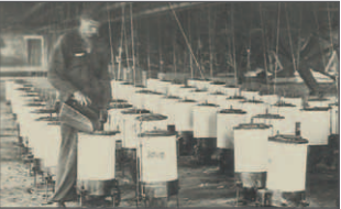
Brenner beim Befüllen der Schürapparate auf dem Ringofen um 1925
