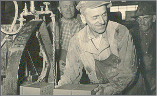
Abnehmen der Formlinge von Hand an der Schneckenpresse um 1930
