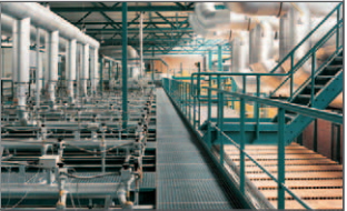
Öl- und Gasbrenner auf einem modernen Tunnelofen um 2004
