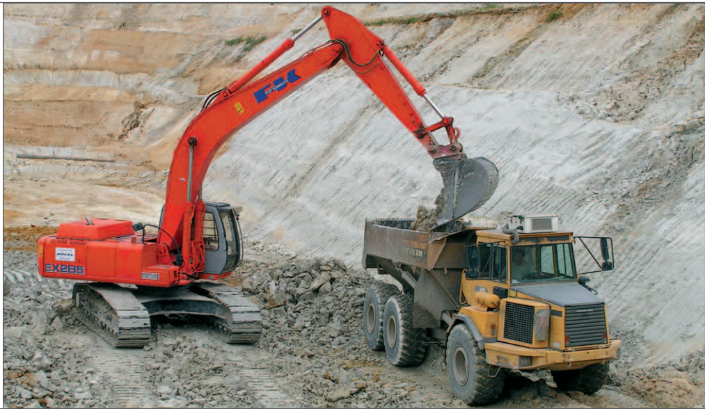
Abbau von Ton mit Hydraulik-Raupenbagger und Muldenkipper-LKW
